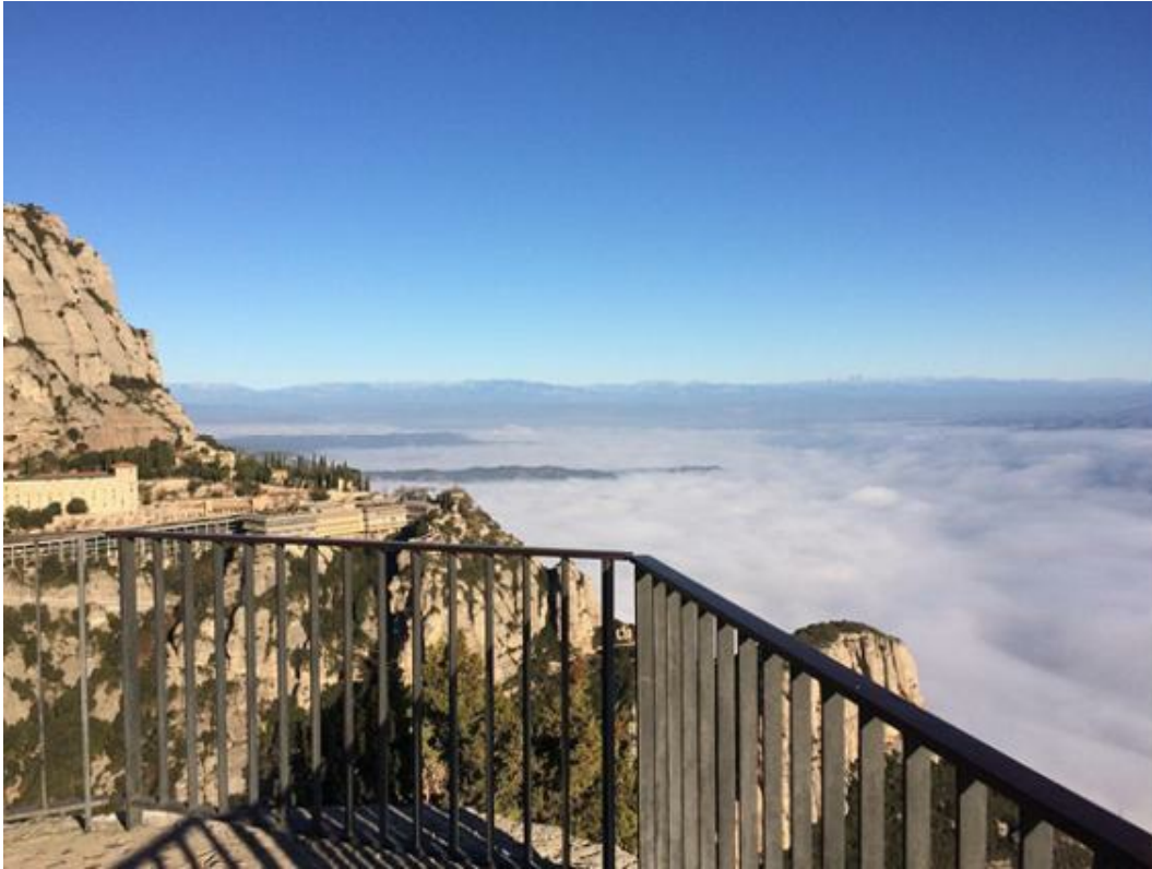
Baranda de protección del mirador de la cruz de San Miguel de Montserrat https://patrimonicultural.diba.cat/element/creu-de-sant-miquel
